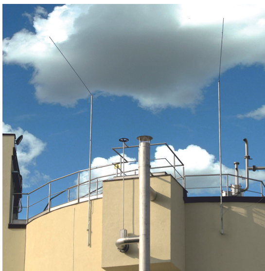
Maszty skrzywione w celu zwiększenia kąta ochronnego strefy wybuchu zbiornika.
