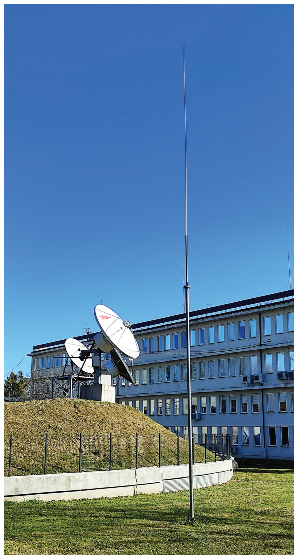
Maszt na fundamencie H=13500mm AH35061
