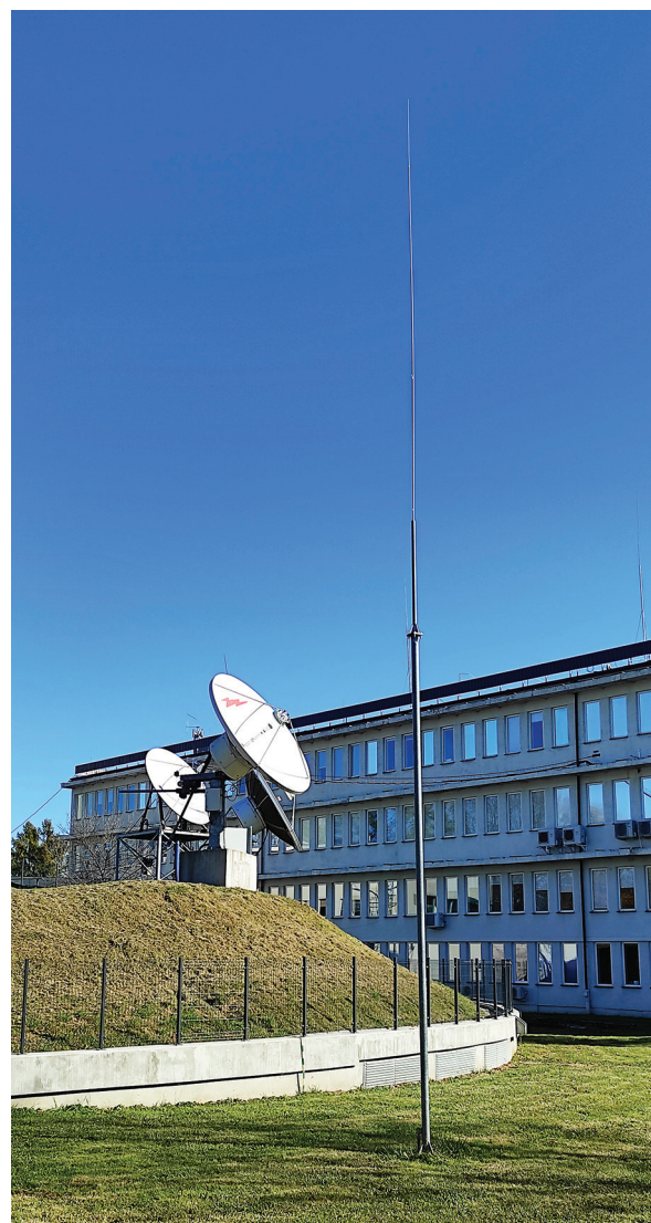
Maszt na fundamencie H=13500mm AH35061
