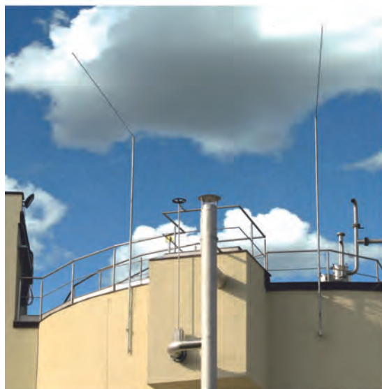
Maszt skrzywiony w celu zwiększenia kąta ochronnego strefy wybuchu zbiornika.
